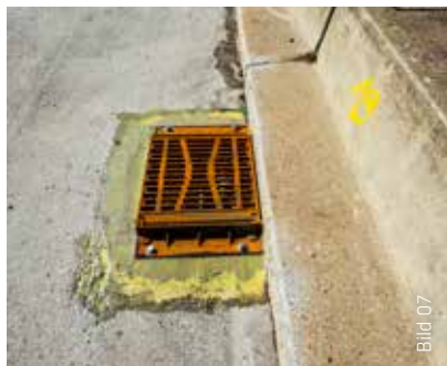
Um keine Überraschungen beim Einbau des in der Anfangsphase flüssigen Kunstharzes zu erleben, muss jede noch so kleine Fehlstelle abgedichtet werden: Hier die Sanieraufsätze der Einlaufschächte.
