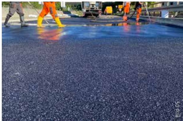
Die aus den Hohlräumen des ATG entweichende Luft wird in Form von Blasen sichtbar, solange muss die Flüssigkeit mit dem Schieber eingearbeitet werden.
