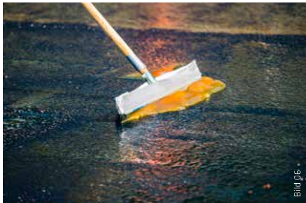
Nach kurzer Zeit sind keine Blasen mehr zu sehen. Das Sika® Ergodur-1000 HANV wechselt zu einer honigartigen Masse und erhärtet in den Hohlräumen des ATG.
